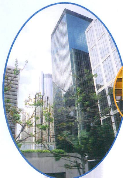
▲アトランタ中心部のビル群 ガラスの多いのが特色。
